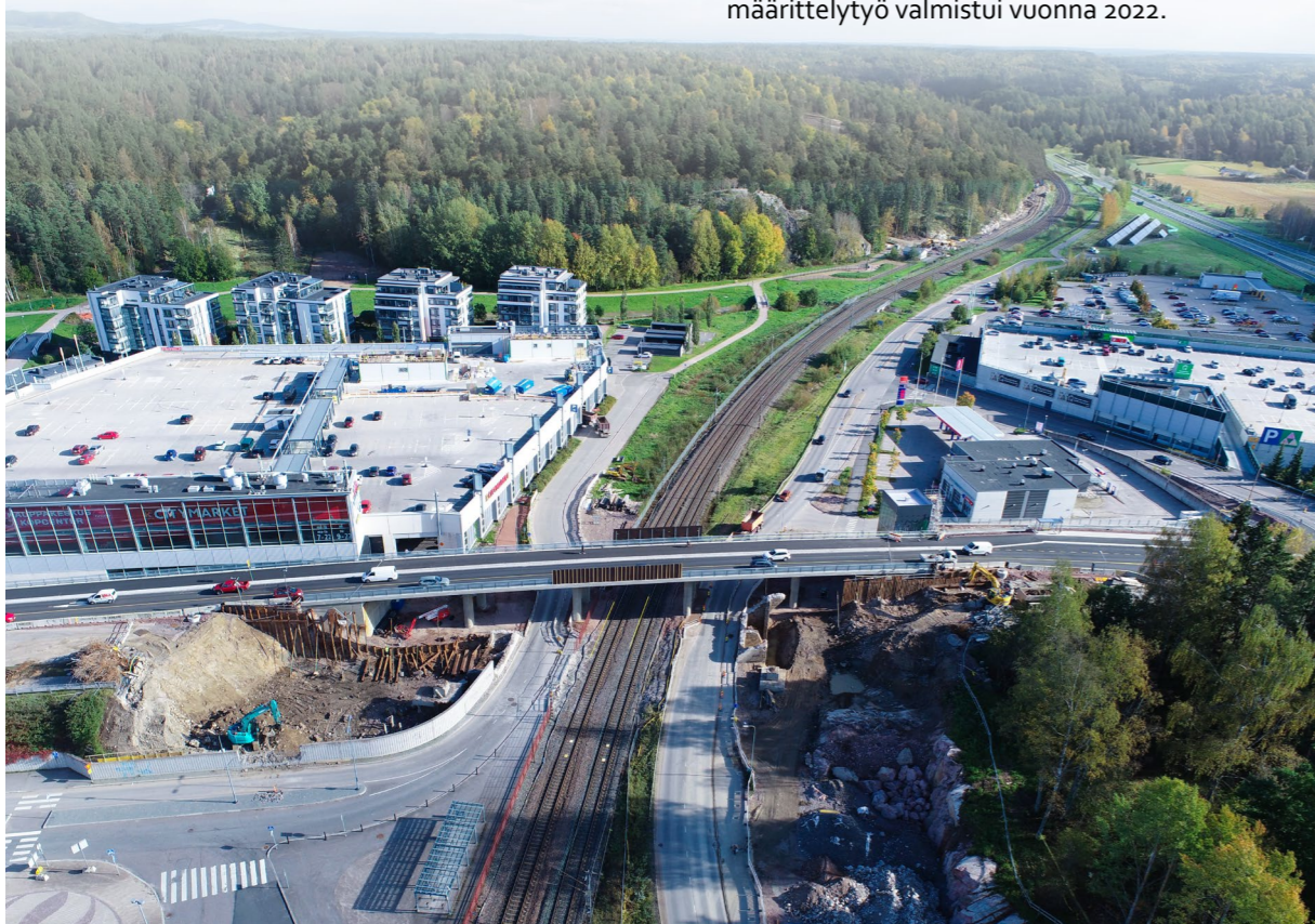
Kirkkonummentien silta valmistuu vuoden 2024 loppuun mennessä.
