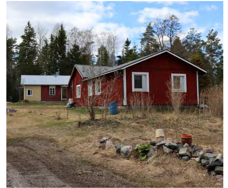
Kuva 45. Rönnkulla, Päärakennus edustalla ja toinen asuinrakennus (osin keltainen) taustalla).
