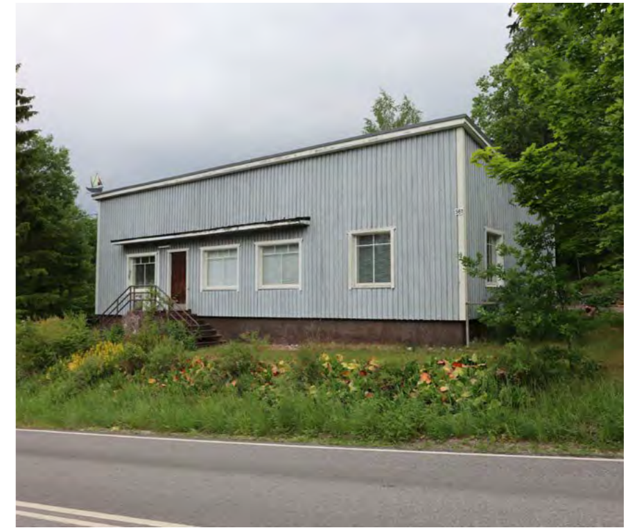
Kuva 36. Vanha Osuuskaupan rakennus.
