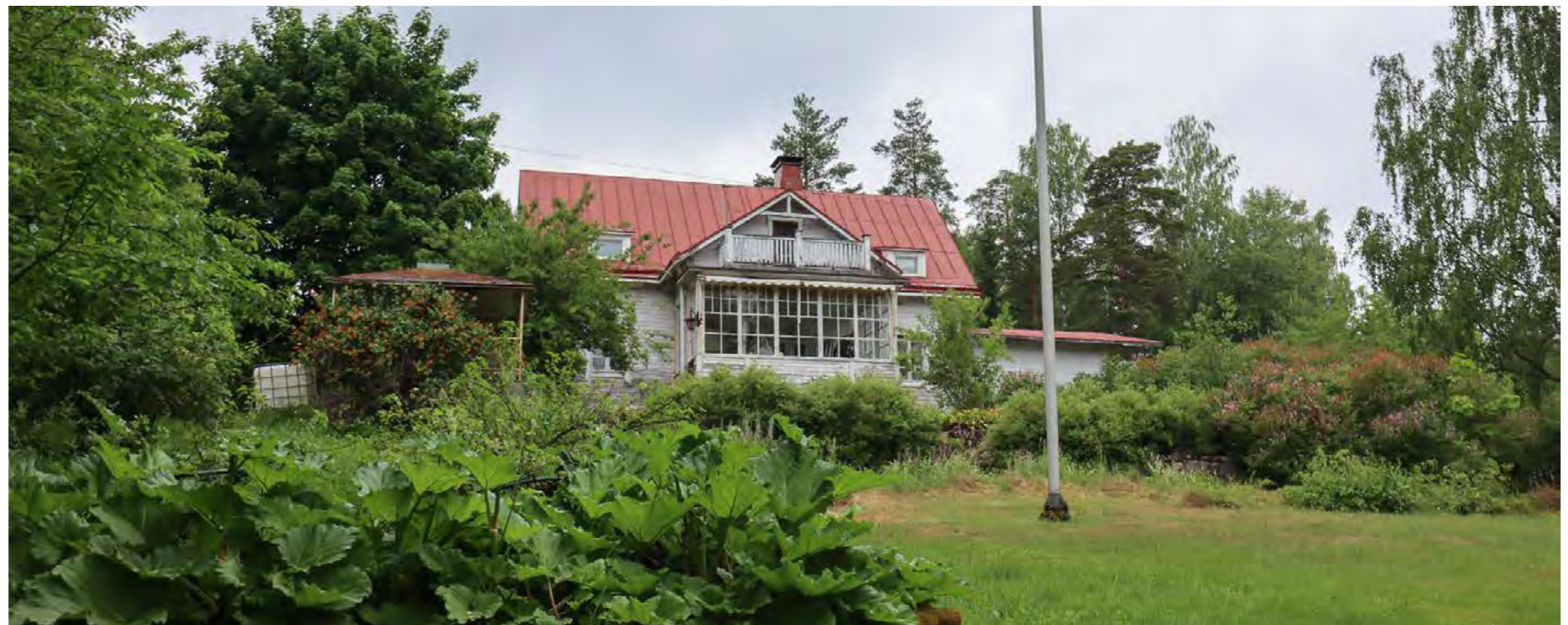
Kuva 42. Granboda, huvilan vasemmalla puolella oletettavasti 50-luvulla lisätty teräsputkirakenteinen huvimaja ja oikealla puolella 50-luvun betoniperustuksinen matalampi laajennusosa, joka toimii mm. sisäänkäyntinä myöhemmin pihalle tehdyn parkkipaikan puolelle.
