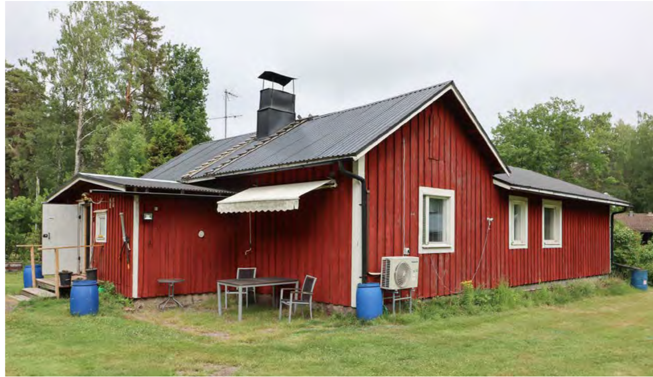
Kuva 41. Rönnkulla, palstatilan luonnonkiviperustuksisen ja savupiipullisen keskiosan asuintiloja on laajennettu myöhemmin L:n muotoiseksi.
