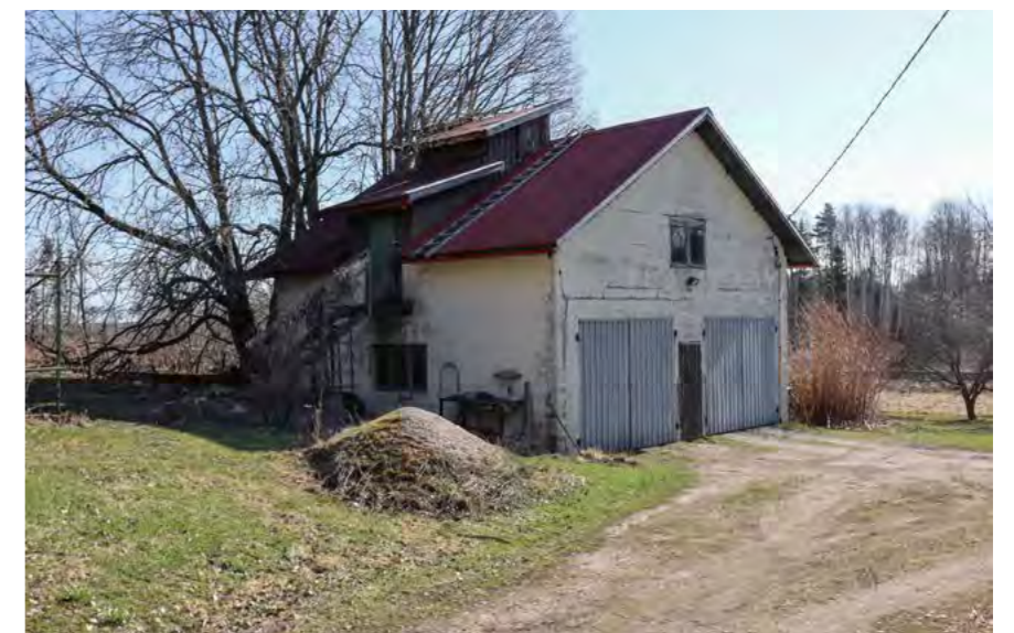
Kuva 70. Ribacka II, kauppapuutarhan talousrakennus.
