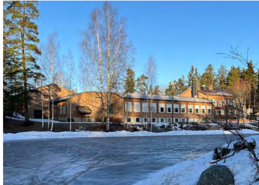
Kuva 31. Bobäckin koulurakennus lounaasta, pelikentän toiselta puolen kuvattuna. Edustalla koulun vanhin, 1950-luvulla rakennettu osuus. Osuus avautuu aikakaudelle tyypillisesti valoisaan ilmansuuntaan, näyttäytyy avoimessa maisemassa edukseen sekä jättää taakseen suojaisan piha-alueen.
