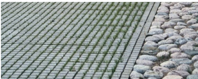
Kuvat 9 ja 10: Parkkiruudut erotettu muista liikenneväylistä luonnonkiviraidalla ja nurmikivilaatailla. (kuva: Benders Oy ja Rudus Oy)
