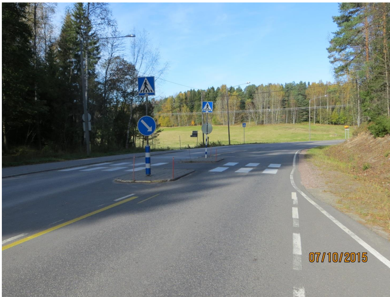
Bild 8: Från Kommuncentrums riktning upphör cykelvägen i korsningen mellan Volsvägen och Kvarnbyvägen. Målet med trafikregleringarna i delgeneralplanen är att genomföra bussturer från korsningsområdet på bilden till det nya bostadsområdet i Kvarnby, varifrån de återvänder till Volsvägen längs vägen som planerats söder om Ingels åkerfält. Syftet är att på det vidsträckta åkerfältet på bilden bygga ett relativt litet arbetsplatsområde (bild: Tero Luomajärvi).
