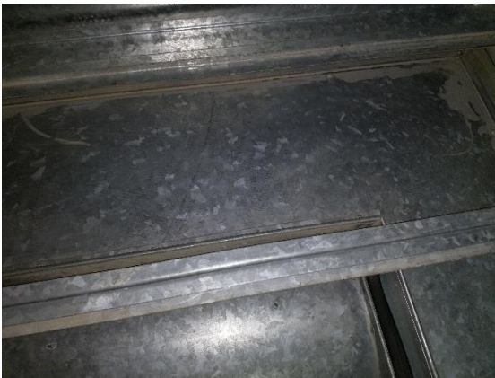
Kuva 2. IV-koneen sisäpinta villan poiston ja puhdistuksen jälkeen
