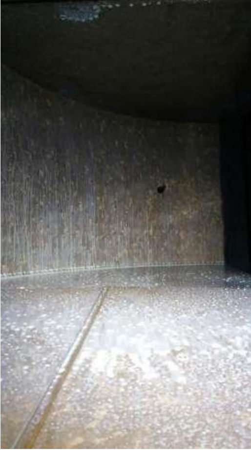
Kuva 4. Tuloilmakanava ennen IV-koneita. Juuri käsitelty Grafoseal aineella.
