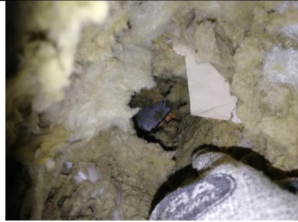
Vanhan osan yläpohjan rakennekerroksia.
