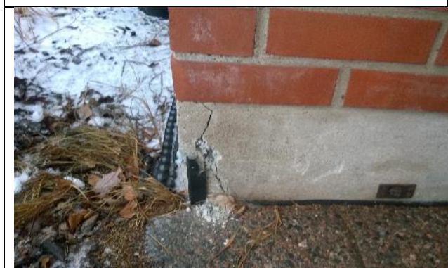
Vanhalla osalla sokkeli on harkkosokkeli, jonka pinnassa on kerros sementtilaastia.
