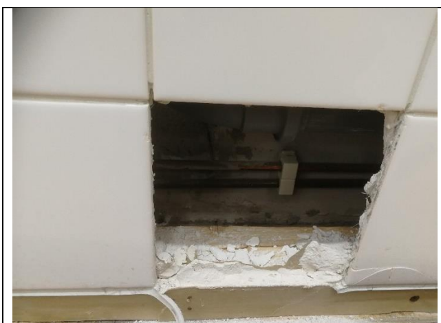
Kotelorakenteet olivat tutkituilta osin kunnossa.
