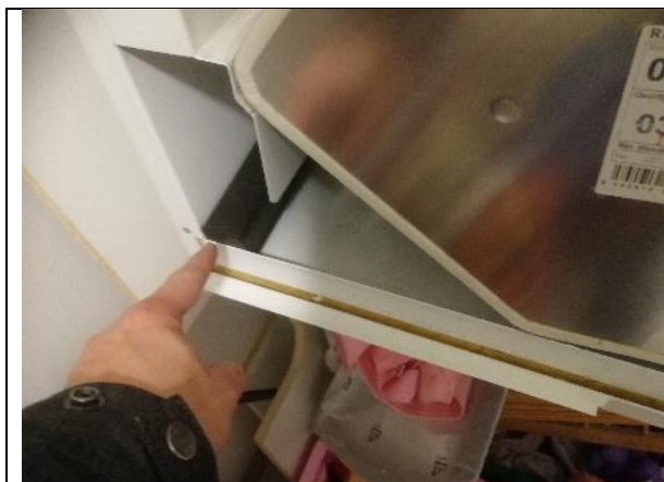
Vallox 145 Ito-kuution tiiviste on sivussa ja mahdollistaisi tulo- ja poistoilmavirtojen sekoittumisen, jos kone toimisi.
