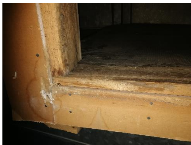
Raitisilmakammiossa puuosat ja kipsilevy kastuneet.
