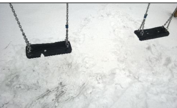
Keinuista puuttui ketjusuoja ja istuinlaudoissa oli halkeamia.
