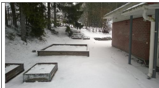
Rakennuksen vanhalla osalla kallistukset osin rakennuksen suuntaan.
