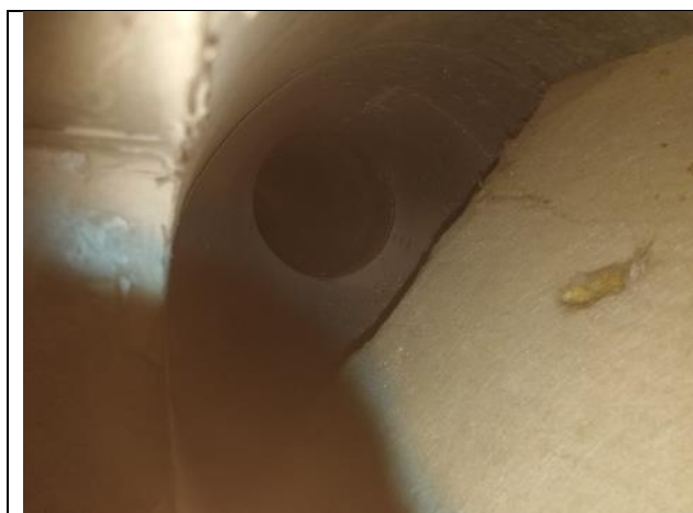
Mineraalivillaa kanavassa tilassa 204
