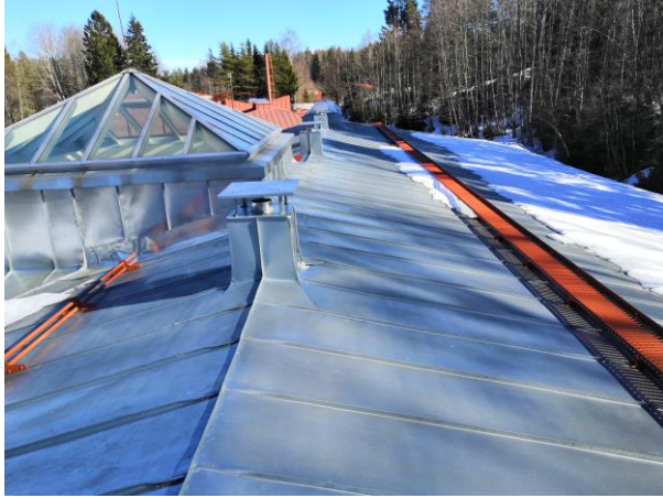
Vesikatolla on yläpohjan harjatuuletusputkia. Tuuletusputkien päät jäävät yläpohjassa harjalaudoituksen päälle.
