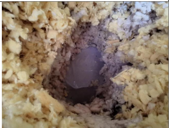
Yleiskuva uuden puolen yläpohjan eristekerroksista sekä sen alla olevasta muovista.
