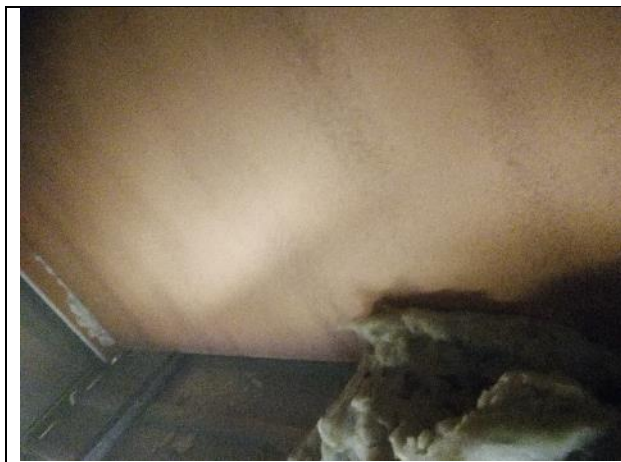
Kipsilevyjä tummentunut keittolan alaslasketun katon sisällä.
