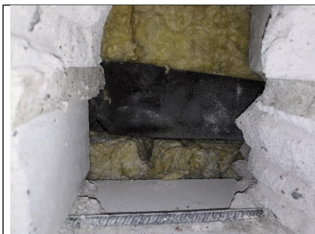
Vanhan osan ulkoseinärakennetta. Sokkelin päällä on bitumikermi.
