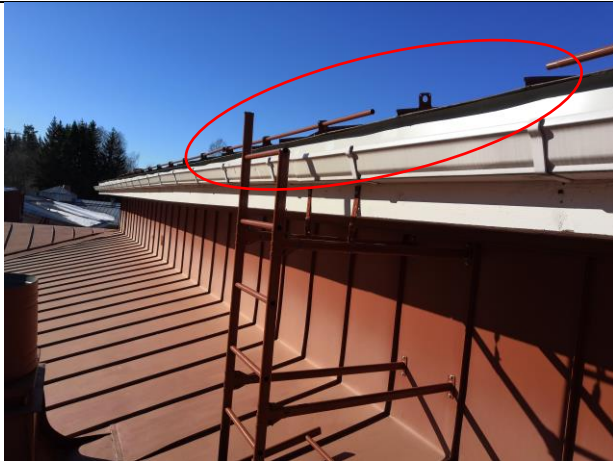
Tikkaat ovat rikki. Lumieste on liikkunut.
