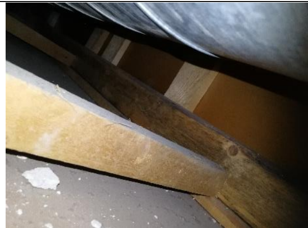
Rakentamisessa käytetty mustunutta puutavaraa. Kiinnityksessä käytetty nauvoja.
