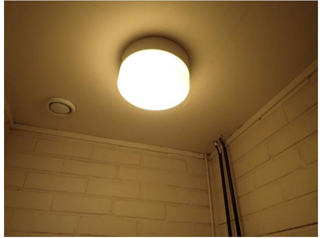
Yleisen wc tilan alkuperäinen hehkulampputyyp- pinen valaisin (vanha siipi)
