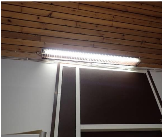
Aulatilán valaistus on toteutettu loisteputkivalaisimilla (vanha siipi)
