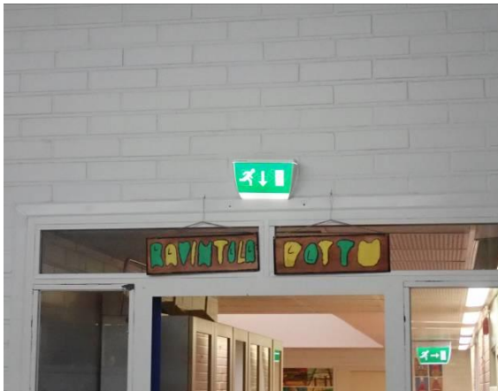
Uudemman rakennusosan poistumistievalaisin
