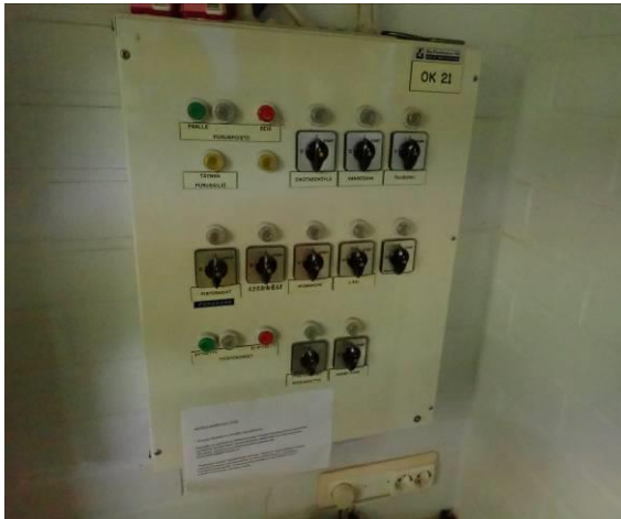
Teknisen käsityötilan ryhmäkeskus(uusi siipi)
