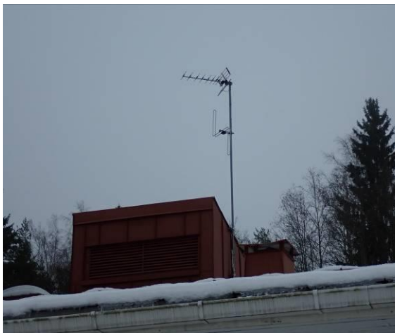
Kiinteistössä havaittiin ns. perinteinen harava-antenni katolla
