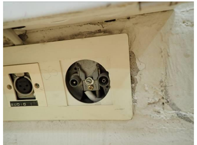
Liikuntasalin antennirasiasta on irronnut kansi
