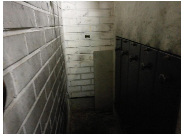
näyte 1 lämmönjakohuoneen seinässä sementtikuitulevy → ei asbestia
