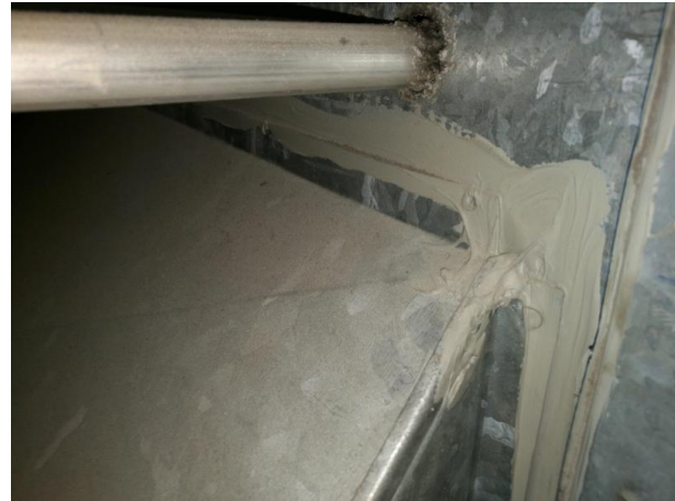
näyte 4 IV-kanavan tiivistemassa → ei asbestia
